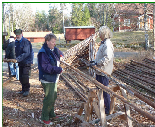
Att bygga ny gårdsgård kräver mycket förarbete
